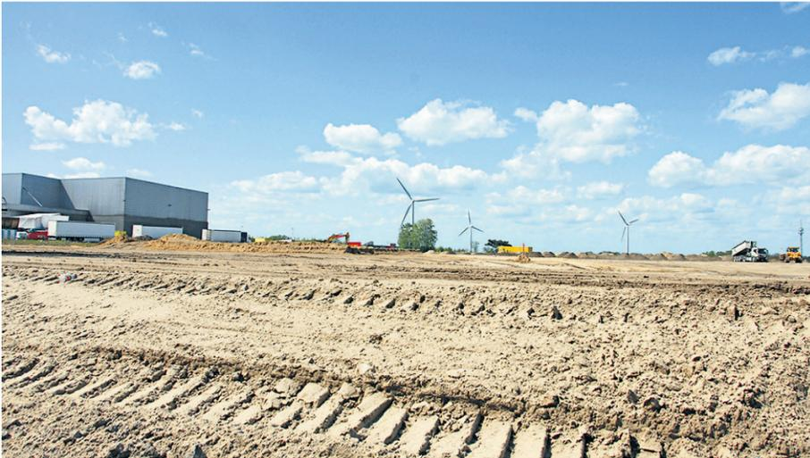
80.000 Kubikmeter Boden werden für die Erweiterung bewegt
