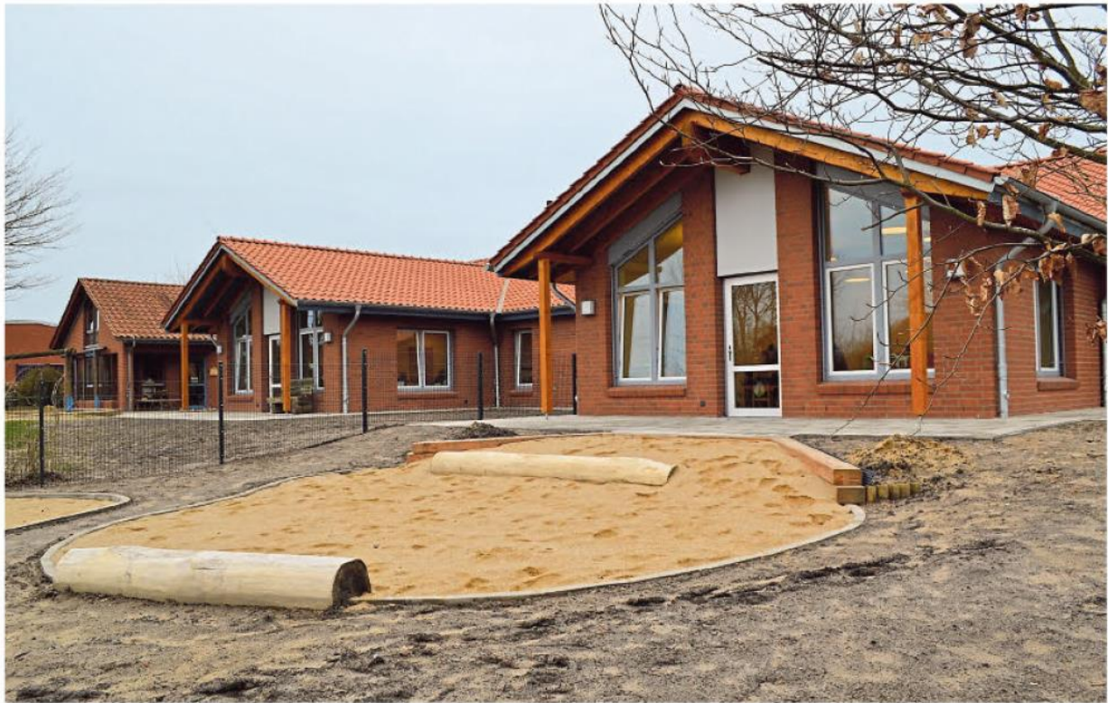
Die Kindertagesstätte in Appel: links die bestehende Einrichtung. Der Anbau (re.) fügt sich hervorragend an das Bestandsgebäude an
