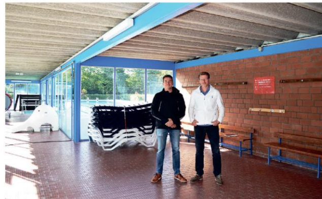
Bauamtsleiter Daniel Heins (li.) und Badleiter Marco Wendt in dem Bereich des Wärmegangs, in den nun Personalraum und Schwimmmeisterbüro umziehen Foto: bim
