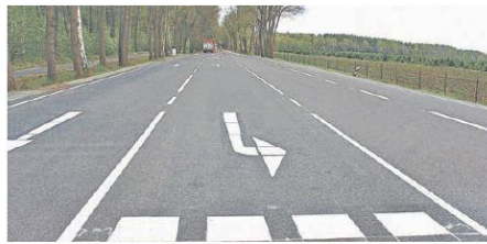
Die B3 ist an der Stelle besonders breit. Eine Querungshilfe für Radfahrer wäre eine sinnvolle Investition in die Verkehrssicherheit. Foto: mi
